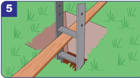
Sie können auch Pfostenträger (z.B. 9x9 cm) verwenden. Diese mittels einer Latte mittig im Loch (50x50x50 cm) platzieren. Nun füllen Sie das Loch mit Fertigbeton auf und glätten die Oberfläche.
